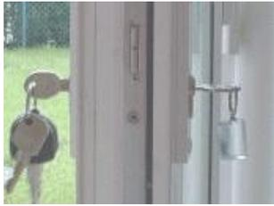
Innen auf der Wohnungs- oder Haustüre (bei Einfamilienhäusern) ist der Schlüssel im Notfall verfügbar und die abgeschlossene Türe verhindert nicht die Flucht aus dem Gefahrenbereich. Helfen kann auch der Einbau eines „Panikschlosses“
