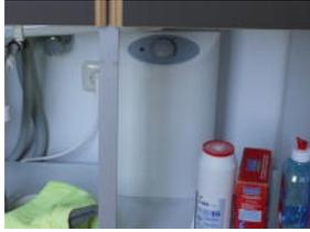
Immer wieder führen unbeaufsichtigte oder vergessene Elektrogeräte (Bügelisen, Herd, Friteuse, ...) zu Bränden. **Vermeiden Sie einen Stand-By-Betrieb** und setzen sie **Kurzzeittimer** ein. Das dargestellte Untertischgerät zur Heißwasserbereitung in der Küche wird ggf. nur wenige Male am Tag zum manuellen Spülen verwendet, zieht aber rund um die Uhr immer wieder Energie aus dem Netz.
